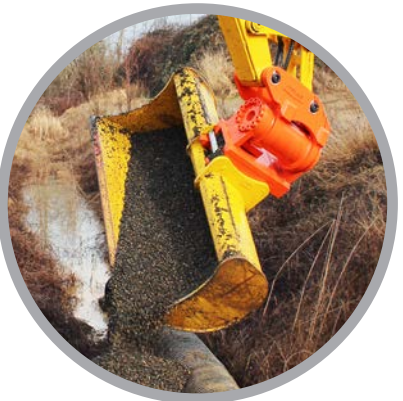
Metering Fill Material
